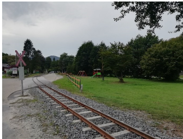
A kisvasút a belterület északi részén
